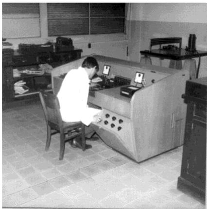
*Figura XVIII. Mesa de calibración de instrumentos de medida del Laboratorio de UTE, en operación hasta la década del 1970.*
